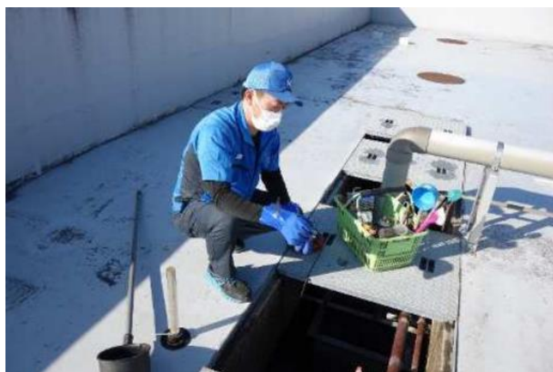
浄化槽の保守点検の様子
