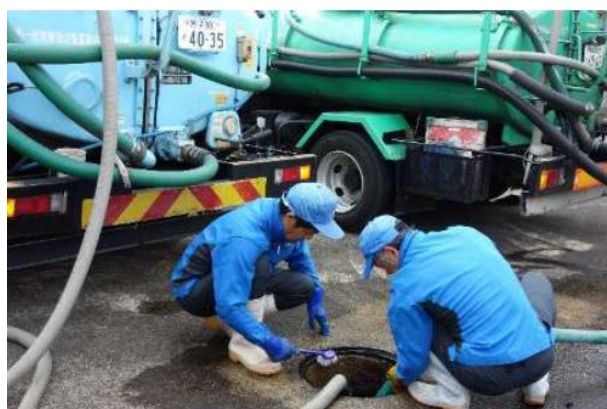
浄化槽の清掃の様子
