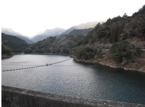
地形の改変を抑えた付け替え道路の例（延岡市）
