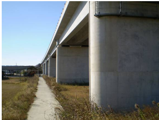
橋脚にスリットを設け、その中に配水管を設けている。（西都市）
