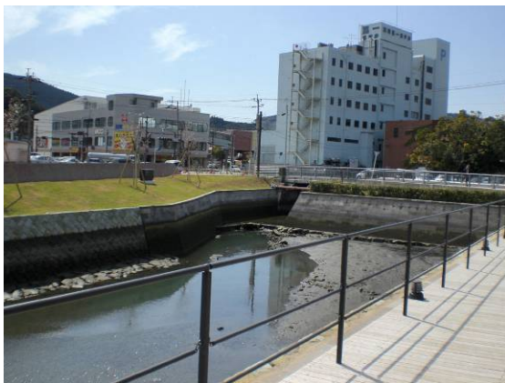
景観に配慮した透過性の高いデザインの例 （日南市）
