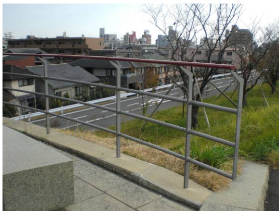
ボルトやナット類の突起を抑制した防護柵の例 (宮崎市)
