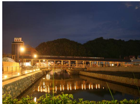
良好な景観を演出する照明の例（日南市）
