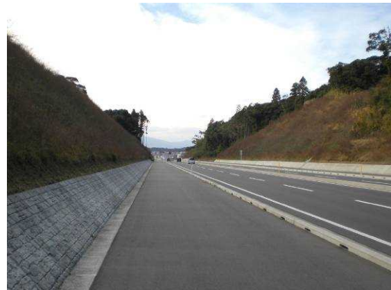
法尻に防草対策を行った例 (宮崎市)
