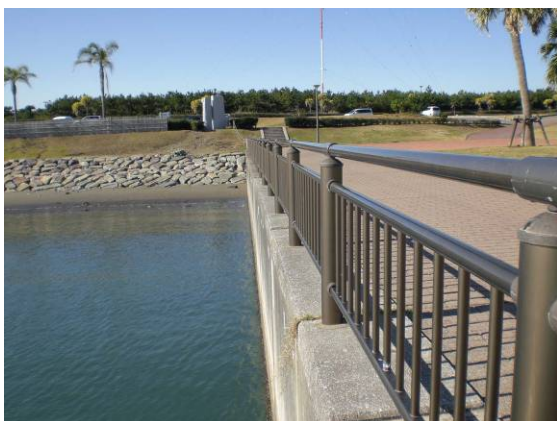
過度な装飾を施していないシンプルな形状の防護柵の例（宮崎市）
