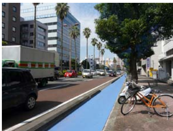
舗装の彩度が高く浮き立った印象になってしまった例
