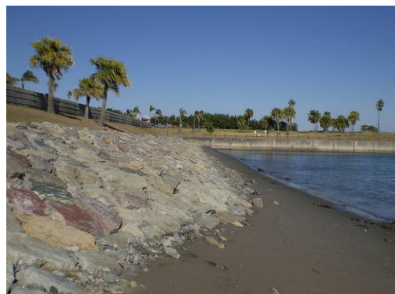
自然石を活用し、丸みを帯びた断面形状をしている防波堤の例（宮崎市）
