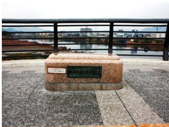
旧橋の親柱をベンチとして再利用した事例 (延岡市)
