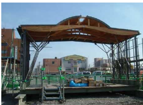
工事着手前に製作された1/3スケールの駅舎大屋根部分の模型(日向市)
