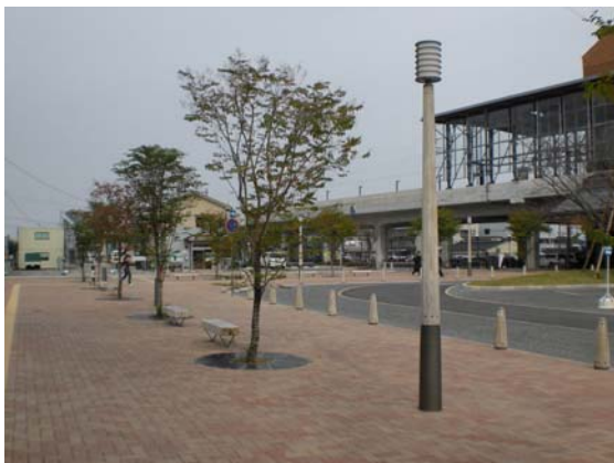
地場産材を活用し、整備を行った例（日向市）
