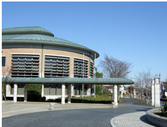
配置や意匠の工夫を行った付帯施設の例 (宮崎市)
