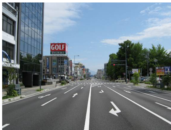
電線地中化により景観への阻害を軽減し、すっきりとした道路景観を形成した例（宮崎市）
