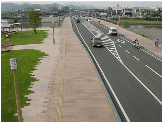
照明施設、添加物等の付属物全体的な調和を図った例（日向市）
