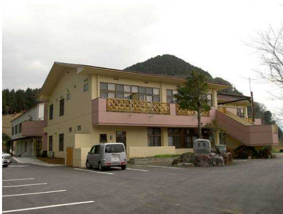
廃校となった小学校校舎を活用し、共生型福祉施設として再生させた例（五ヶ瀬町）
