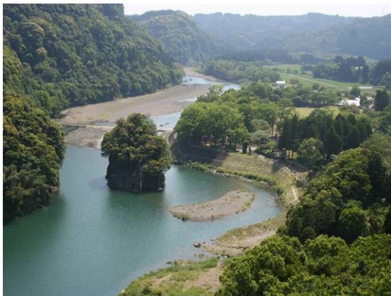
直線化や定規断面によらず、現況の流路を基本とした整備の例（木城町）
