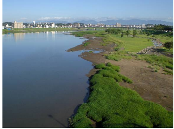
みお筋を固定せず、水際にも植生の回復した例 (宮崎市)
