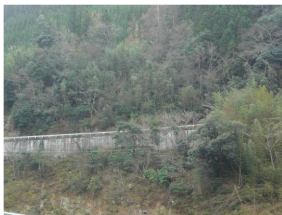
法面の緑化により、その奥の擁壁を見えにくいように配慮した例（諸塚村）
