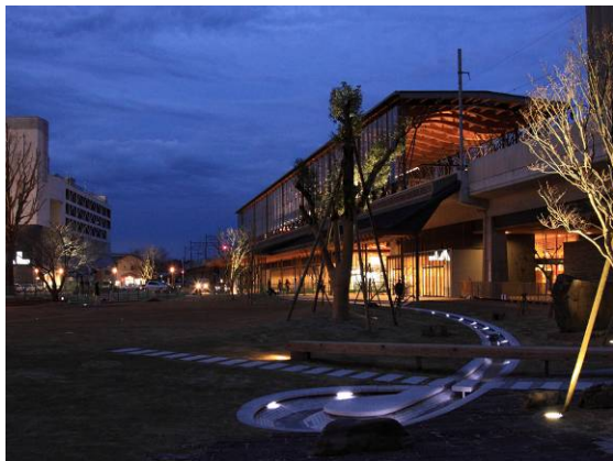
良好な景観を演出する照明の例（日向市）
