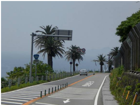
道路標識類が景観の阻害要因となっている例 (対策前)
