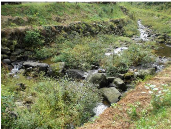
護岸の法勾配に変化をもたせた例（高千穂町）
