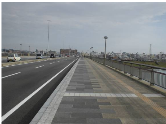
周辺から浮き立った印象とならないよう落ち着いた舗装の例（宮崎市）
