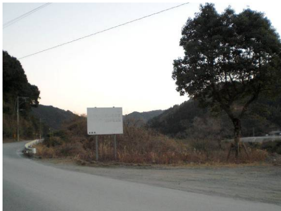
記載内容が消えて読めなくなった不要な看板の例
