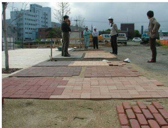
舗装材を敷設し、劣化状況等を確認している様子 (日南市)
