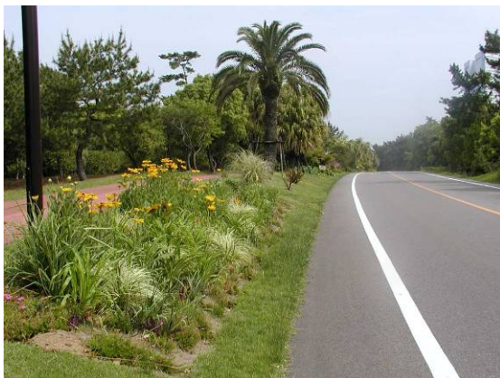
断面形状の工夫により、地形改変を抑制したことで、良好な景観が保全されている例（宮崎市）
