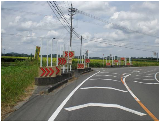
標識類の整理・統合がされておらず、雑然とした印象になっている例
