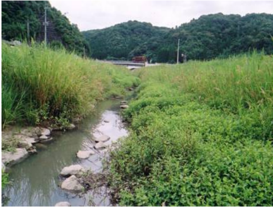
みお筋を固定せず、水際にも植生の回復した例 (串間市)
