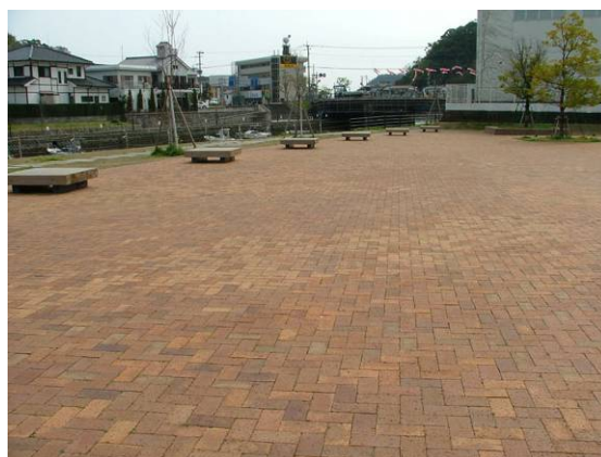
広場にレンガ舗装を用いた例（日南市）
