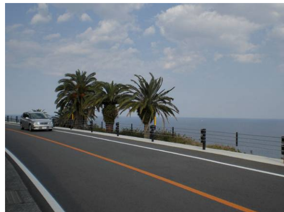
透過性の高いガードケーブルを採用し、海が見えるように配慮した例（宮崎市）
