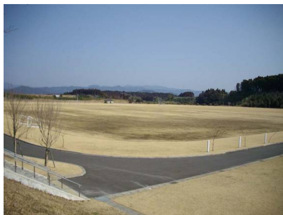
既存樹木の保全・活用により、造成地周辺との緑の調和に配慮した例（高原町）
