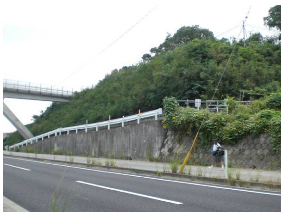
隣接する擁壁の勾配が異なっており不自然な印象となっている例
