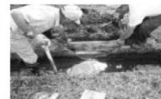
破損水路の補修(長寿命化)
