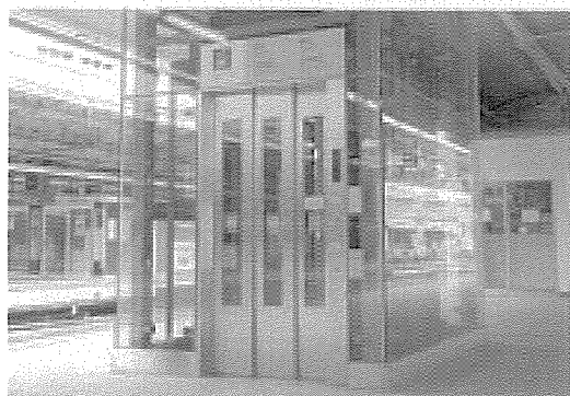
エレベーター
