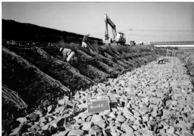
木材等を活かした河川伝統工法（護岸工）
