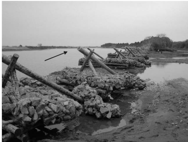
木材等を活かした河川伝統工法（水制工）
