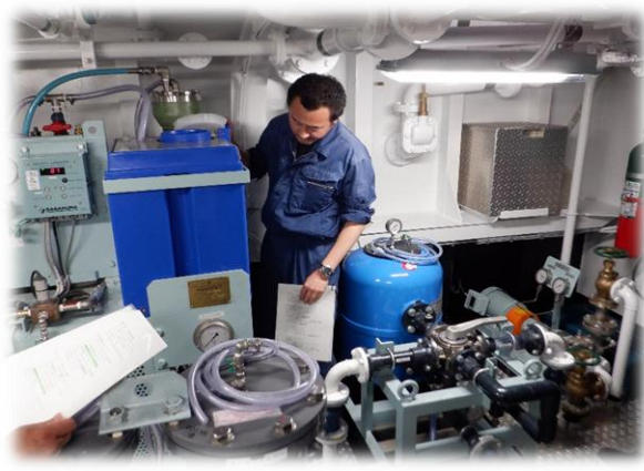
〈写真〉造水機の機関整備
