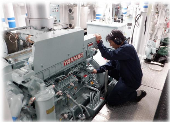
〈写真〉発電機の機関整備
