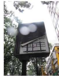
シート材がはがれかかった状態
