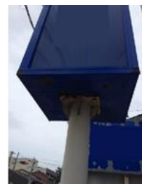
支柱・広告板接合部
