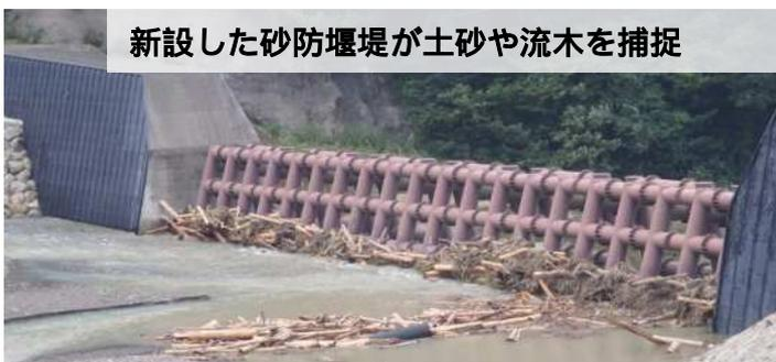
新設した砂防堰堤が土砂や流木を捕捉
