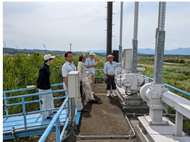
出水期前の水門点検（追手川樋門）
