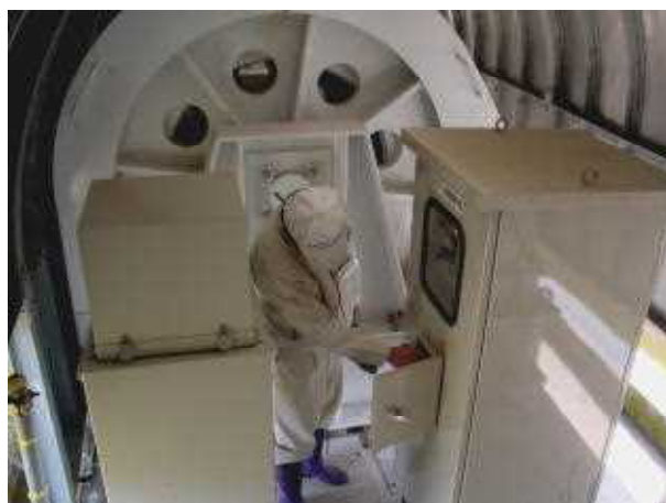
ゲート操作の様子(テンターゲート)
