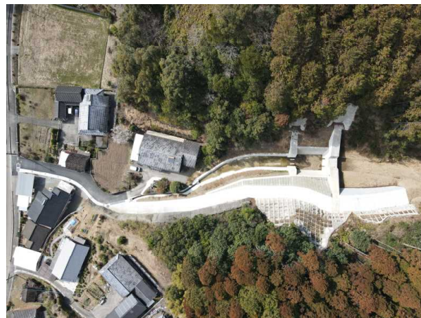
令和5年3月 完成
