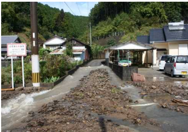
日向市西川内谷川4 被災状況(H24. 10. 7)
