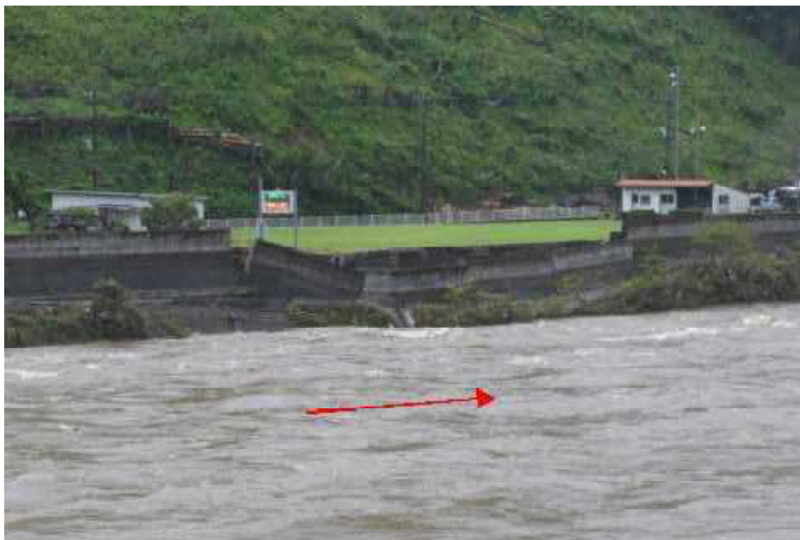
< R 4. 9 台風14号による護岸被災状況（浦之名川：高岡町平木場地区） >
