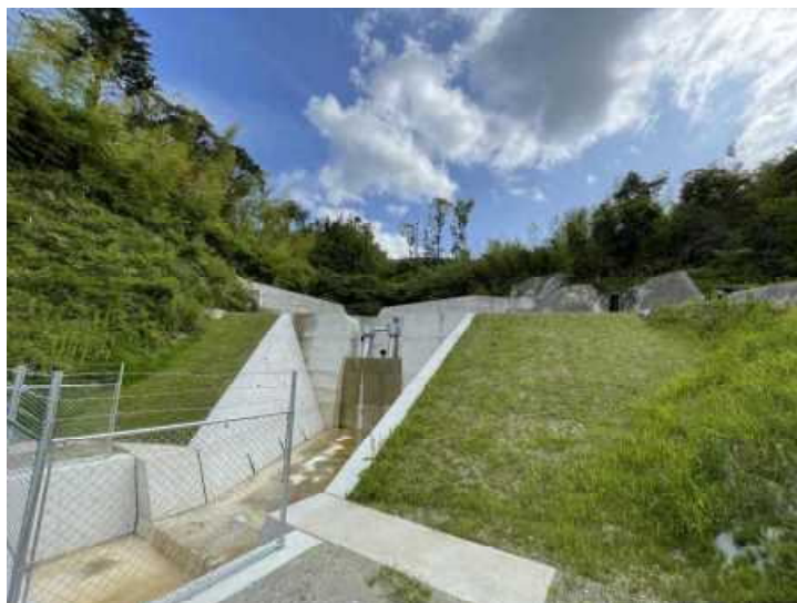
〈崎ノ田谷川 2 副堰堤～垂直壁〉
