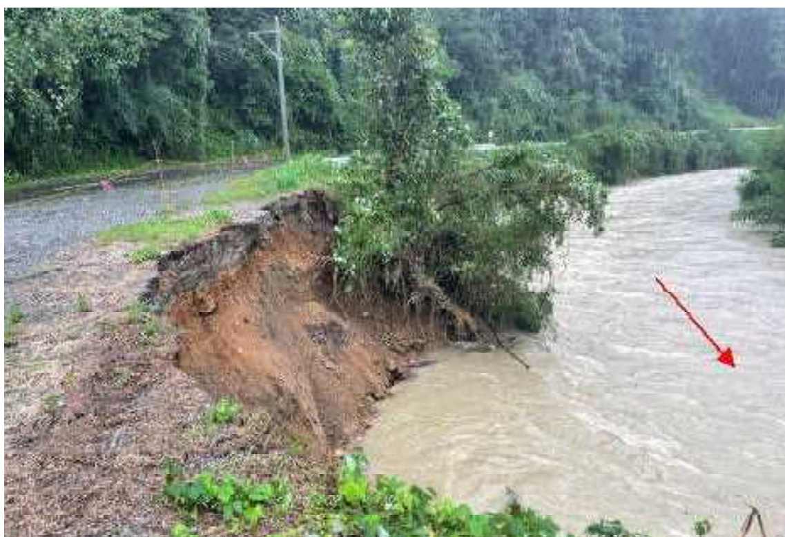
< R 4. 9 台風14号による護岸被災状況（浦之名川：高岡町平木場地区） >
