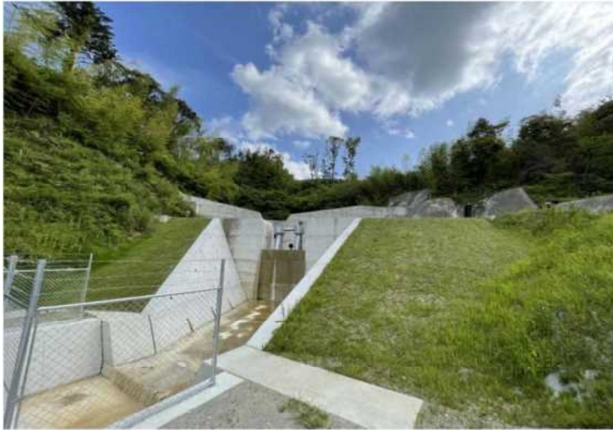
〈崎ノ田谷川2副堰堤～垂直壁〉
