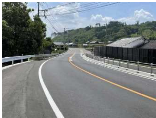
<向高工区>（R4完了）
