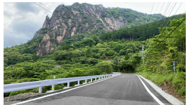
【上祝子綱の瀬線整備状況（下鹿川工区）】
