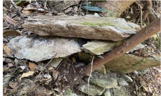
【法面の転石状況】
