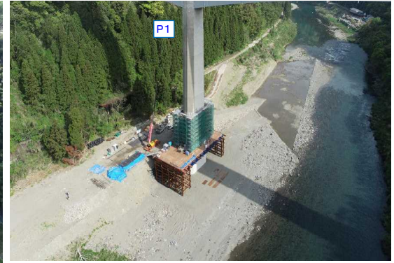
【P1橋脚補強】
