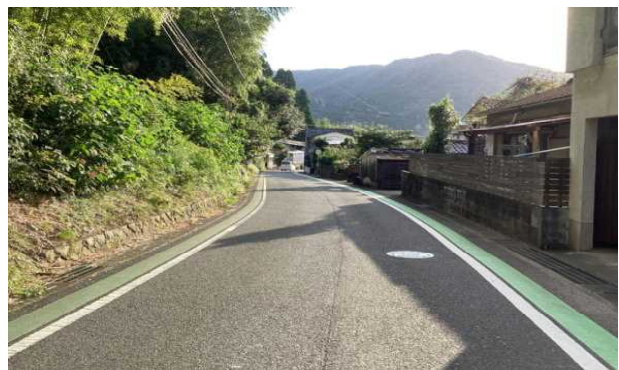
【小野工区道路状況】
