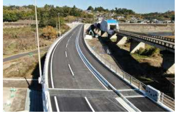
【完成した川水流橋】
