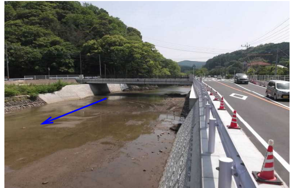
【橋梁完成（飛川橋）】
