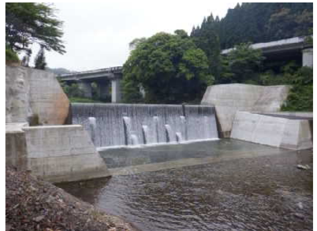
東岳川 砂防堰堤改築
