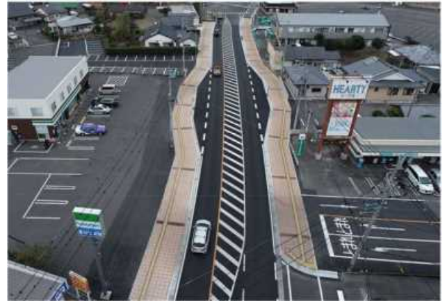
都城霧島公園線 街路整備
