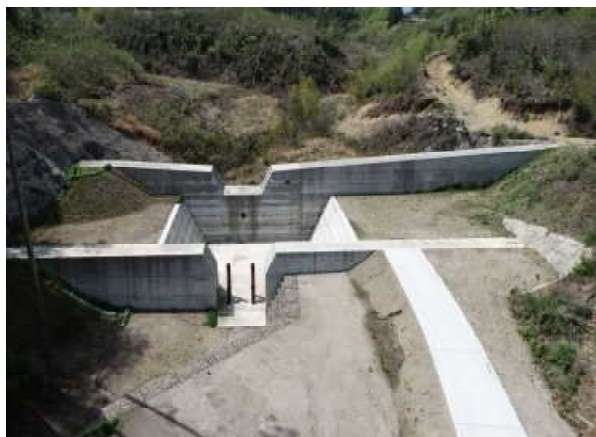
砂防事業－瀬之口川砂防堰堤（R4 完成）
