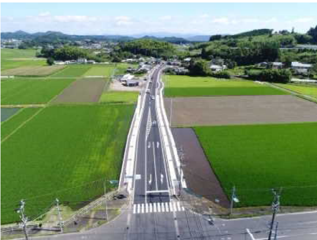
国道221号 歩道整備
