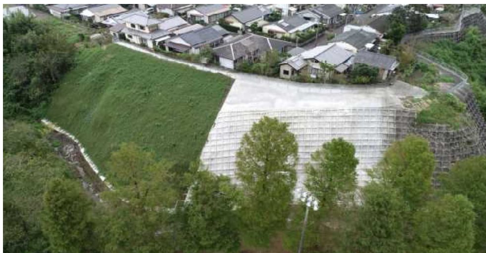
下叢原地区（H30 完成）
