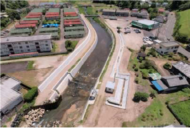
山田川 河川改修
