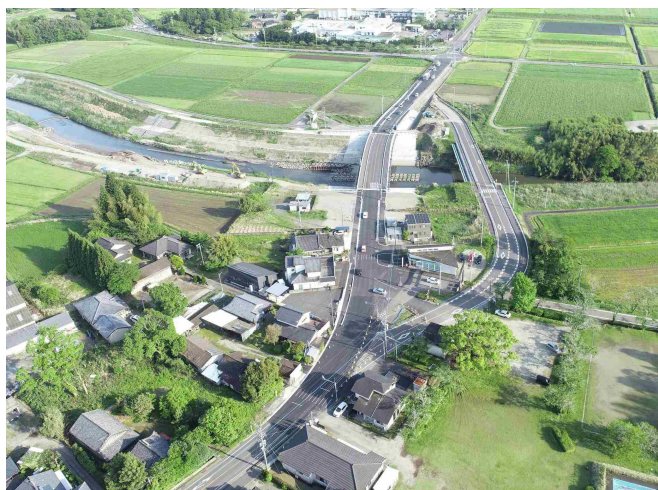
横市川 河川改修
