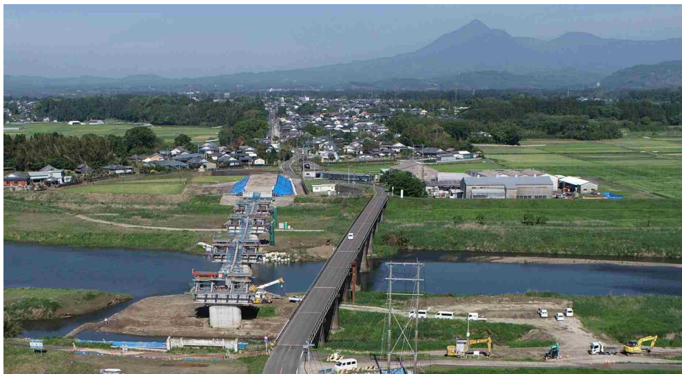
高城山田線 道路整備
