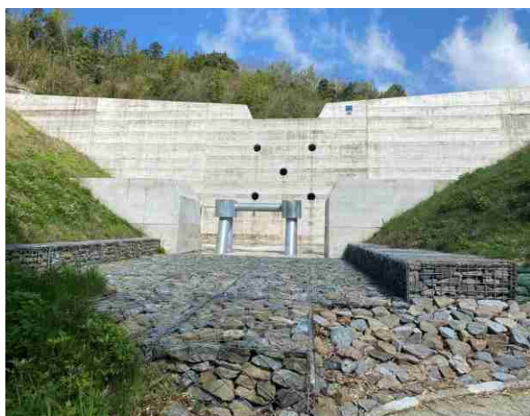
砂防事業－高野谷川砂防堰堤（R5 完成）
