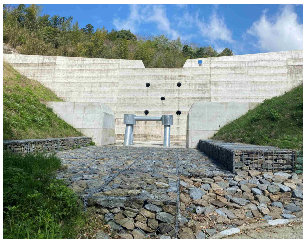
高野谷川 砂防堰堤整備
