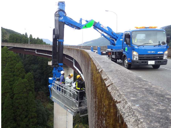
橋梁点検（県道都城北郷線）（R4実施）
