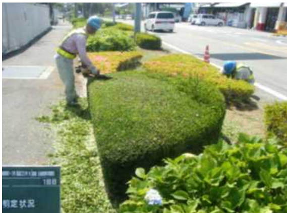
樹木管理（国道220号）（R4実施）
