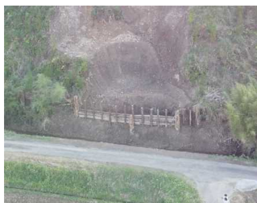
復旧完了（土砂除去）
