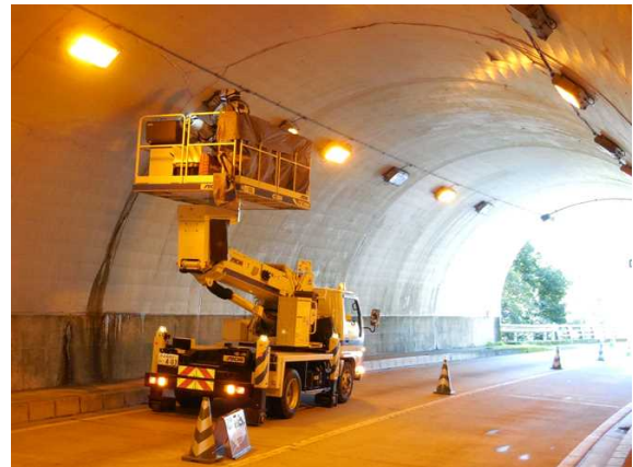
トンネル点検（国道222号）（R4実施）
