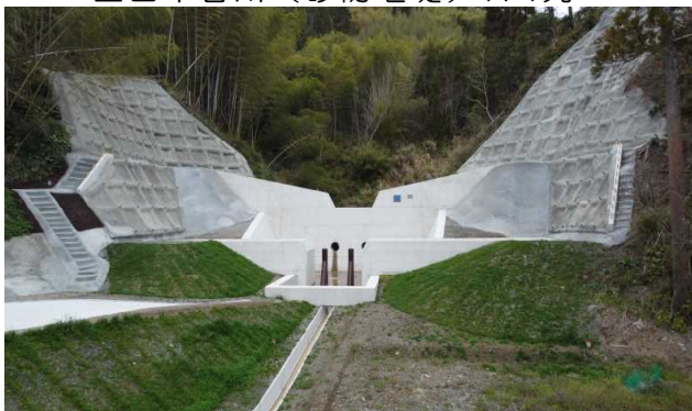
上田平谷川（砂防堰堤） R4完
