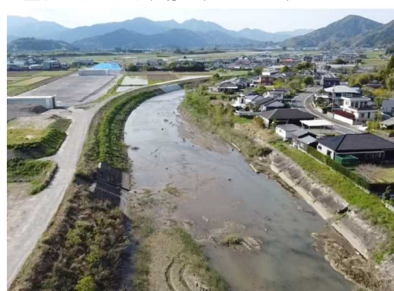
益安川 河川改修（H14～）
