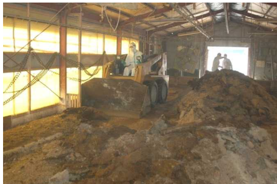
重機による除去作業
