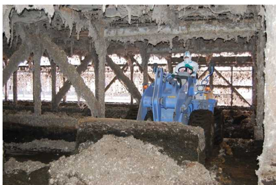
重機による除去作業
