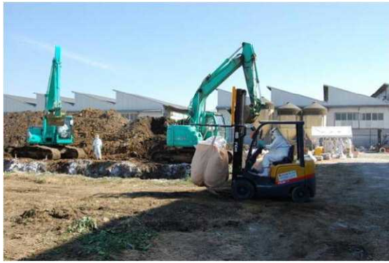
フレコンバックをフォークリフトで運搬
