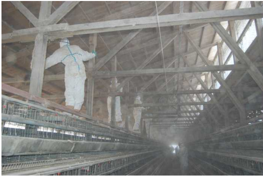
ケージに登って柱、梁のすす払い
