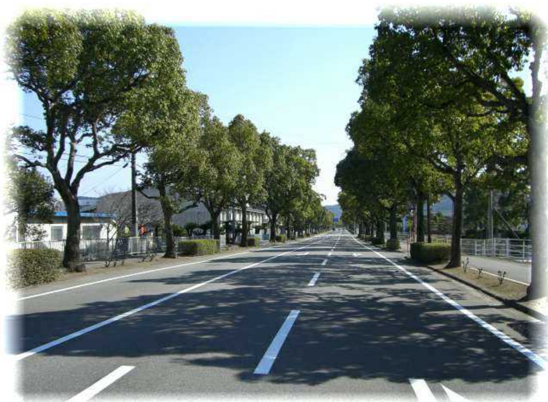
主要地方道 日知屋財光寺線（日向市大字日知屋 細島港付近）
