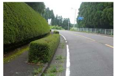
歩道部の寄植を撤去する
