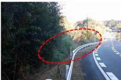
撤去や間引きを行う
