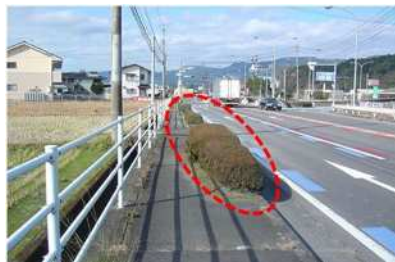
植栽帯を撤去し歩道にする
