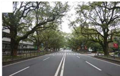
植栽地区（楠並木・ 県道宮崎島之内線）
