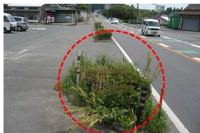
植栽帯を撤去し歩道にする
