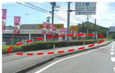
植栽帯を撤去し歩道にする
