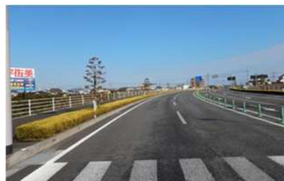
国道327号日向バイパス 植栽状況
