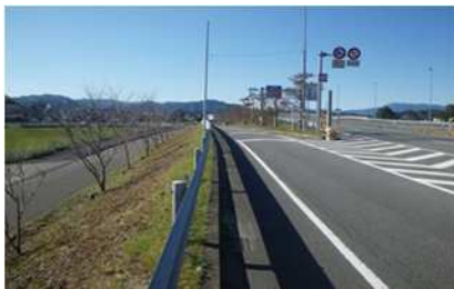
県道延岡インター線 植栽状況
