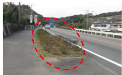
植栽帯を撤去し歩道にする
