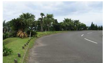
県道都井岬線 植栽状況
