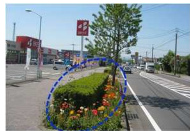
寄植を撤去し、現状と同水準の維持管理を行う
