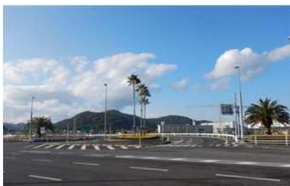
国道327号日向バイパス 植栽状況
