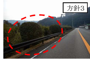
間引きを行い眺望を確保する（国道10号）
