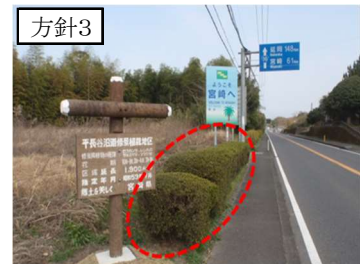
玄関口としてのリニューアル整備を行う（国道10号）
