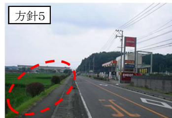
間引きや植替えを行う (国道 219 号)
