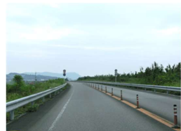
自然植物の伐開による眺望の確保を行う (県道延岡インター線)
