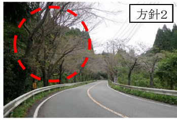
間引きや植替えを行う (国道 388 号)
