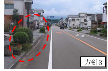
撤去や間引き、植替えを行い、現状と同水準の維持管理を行う。(国道 222 号)
