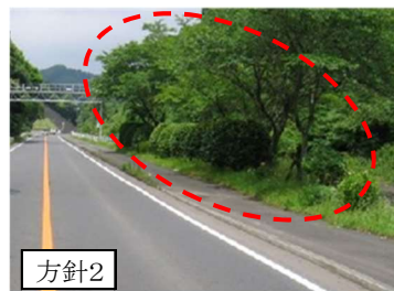
間引きや植替えを行う（国道269号）
