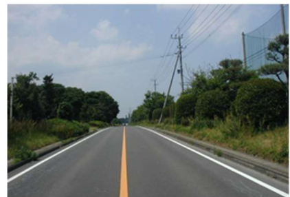
沿道修景植栽地区 (牧の原地区) 県道都城霧島公園線
