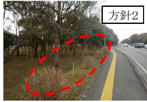
現状と同水準の維持管理を行う（国道10号）
