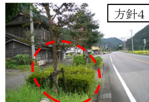
寄植を撤去し芝生等への植替えを行う（国道326号）
