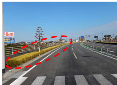
周辺景観や地域活動と調和した整備と維持管理を行う (国道 327 号日向バイパス)
