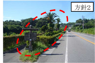
植栽の間引きや撤去、海側の除草や伐開を行う (国道10号)
