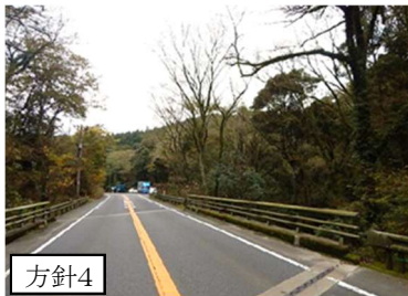
除草や伐開を行う（国道10号）
