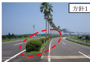
高木は残し、寄植の撤去や植替えを行う (国道220号)
