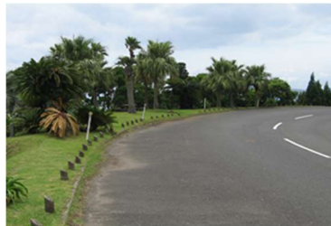
植栽状況（都井岬） 県道都井岬線
