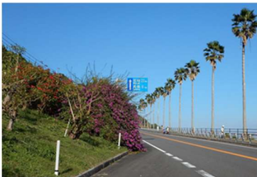
植栽状況（堀切） 国道 220 号
