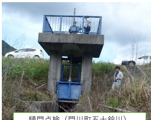
樋門点検（門川町五十鈴川）
