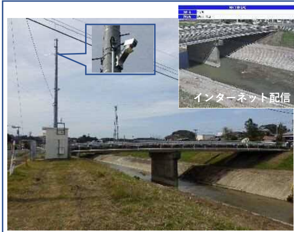
(設置例) 大谷川 城の下橋水位観測所
