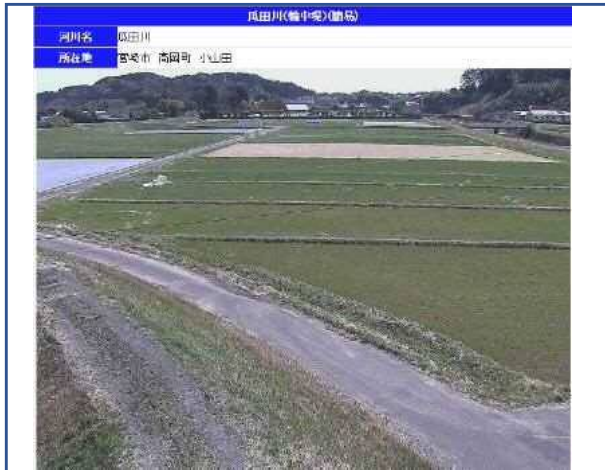
(設置例) 瓜田川 輪中堤 (内水監視)
