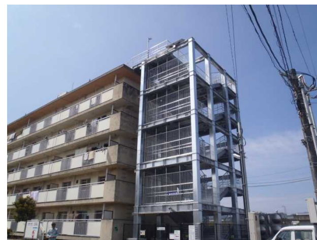
（右）財光寺北市営住宅避難階段
