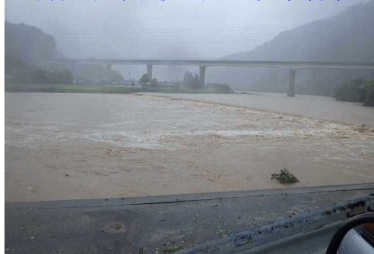
五十鈴川出水状況 門川町小園井堰
