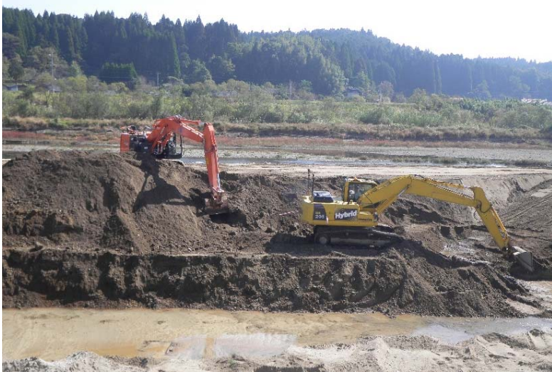
羽月川河道掘削の施工状況 (H30年度)
