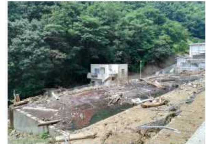
浄水場の被害 (愛媛県宇和島市 吉田浄水場)
