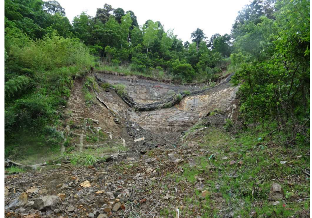
(着工前 被災後)
