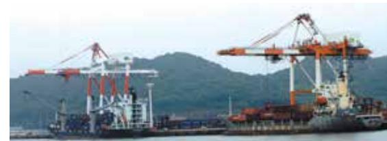
ガントリークレーン荷役作業風景
