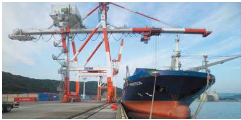
ガントリークレーン(10・14号岸壁)
