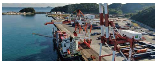
ガントリークレーン荷役作業風景
