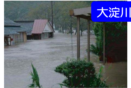
山下橋出水状況
