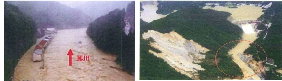
H17年9月台風被災状況(左図: 諸塚地区, 右図: 塚原ダム直下)
