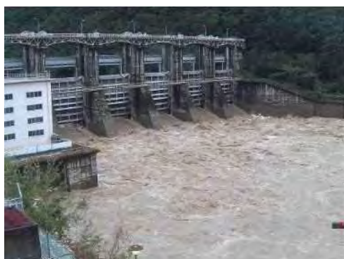
大内原ダムでの通砂状況(台風14号；9/19 10時)
