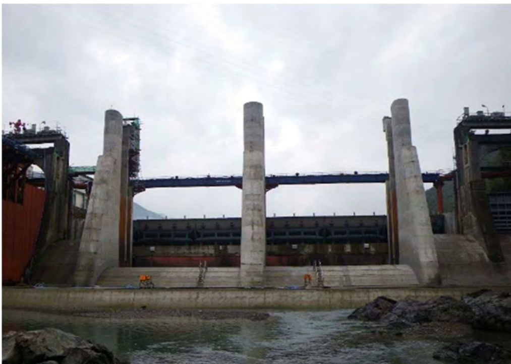
写真 6.1.10 ダム堤体構築後（ダム下流より上流を望む）
