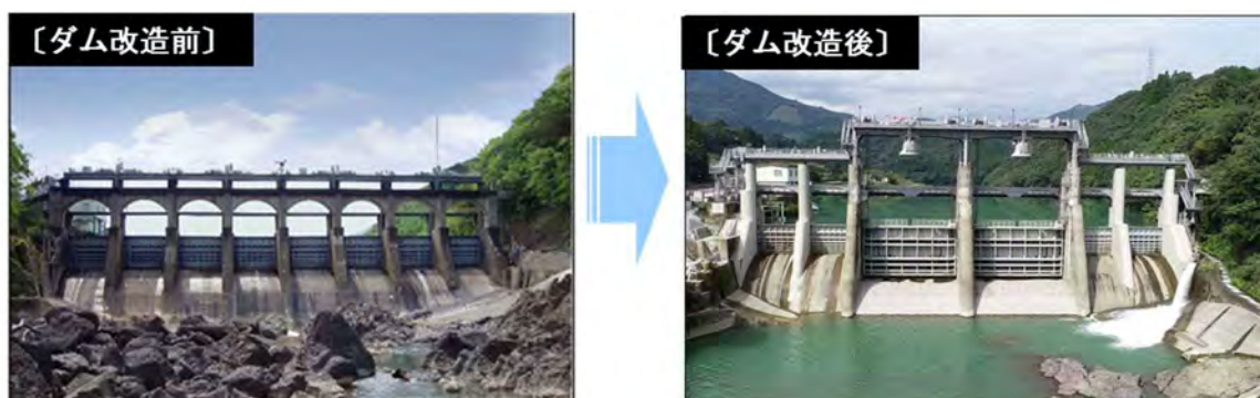
写真 6.1.2 西郷ダム改造工事概要
