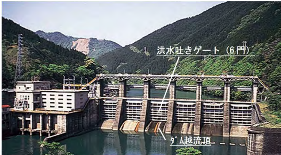
写真 6.1.3 大内原ダム（ダム下流から上流を望む）
