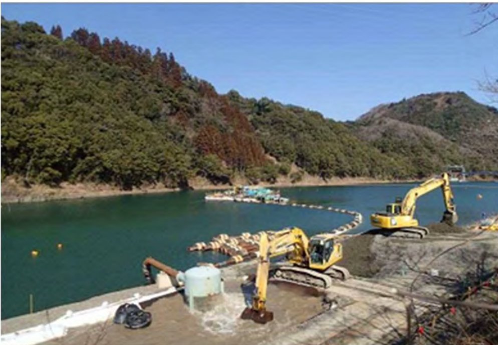
写真 6.1.13 西郷ダム直上流部の土砂浚渫状況
