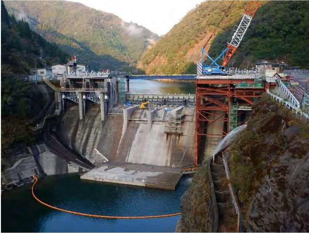
写真 6.1.5 ゲート撤去及びダム堤体切り下げ状況（ダム下流左岸より上流を望む）
