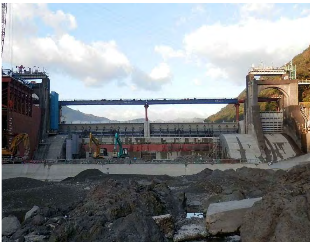
写真 6.1.8 ダム堤体切り下げ後（ダム下流より上流を望む）
