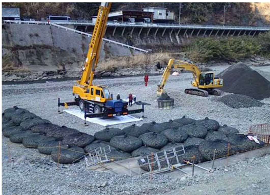
写真 6.1.16 袋詰玉石の製作
