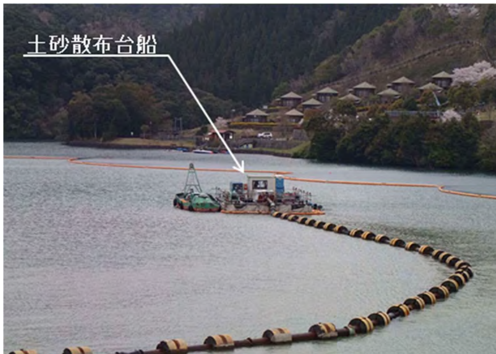
写真 6.1.15 覆砂工事实施状況（大内原ダム調整池内）
