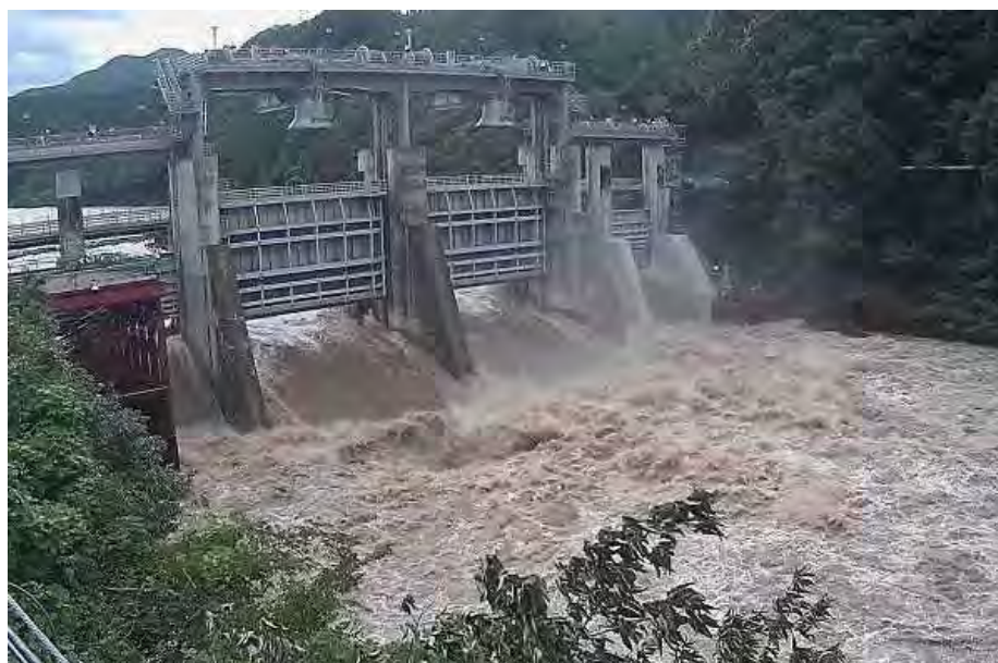
写真 6.2.1 西郷ダムでの通砂状況(台風 18 号；9/17 17 時)
