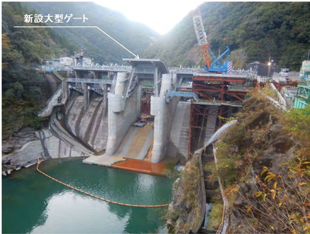
写真 6.1.7 新設ゲート設置後（ダム下流左岸より上流を望む）
