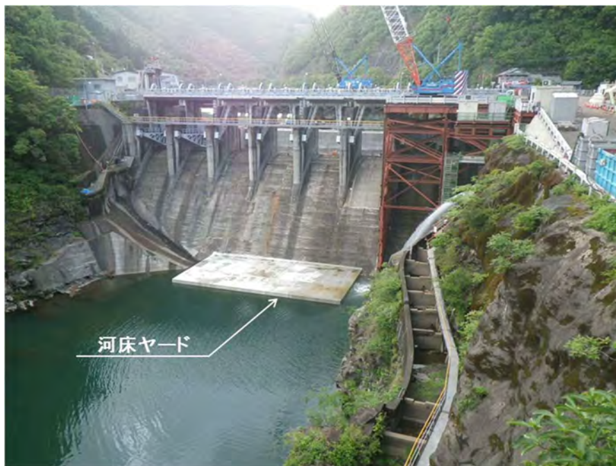
写真 6.1.4 ダム下流河床ヤード構築状況（ダム下流から上流を望む）
