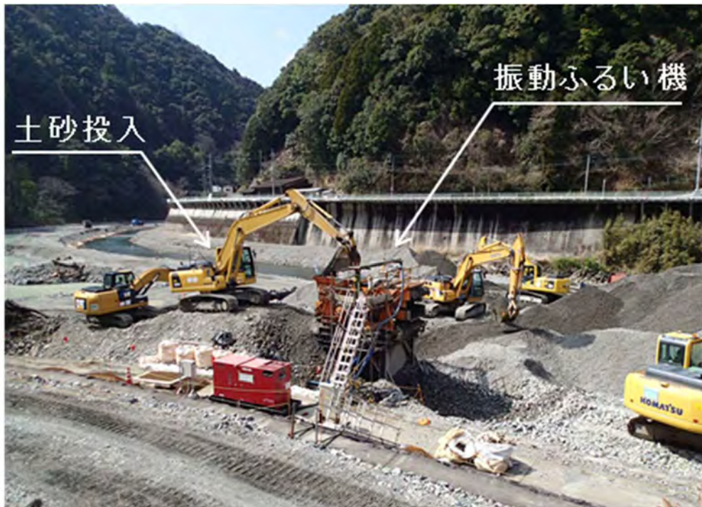
写真 6.1.14 浚渫土砂の分級・洗浄状況（山須原ダム調整池内）
