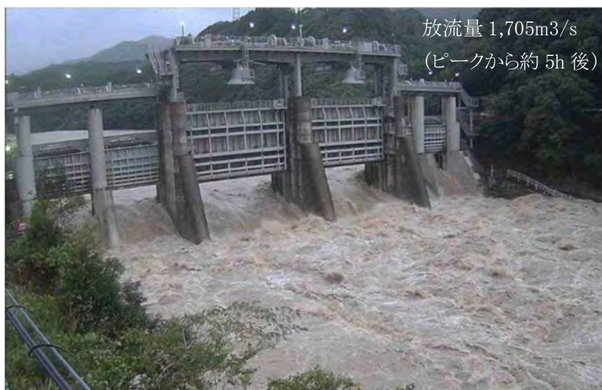
写真 6.2.3 西郷ダムでの通砂状況(台風10号；9/7 6時)
