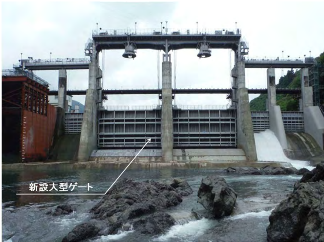
写真 6.1.11 新設ゲート設置後（ダム下流より上流を望む）
