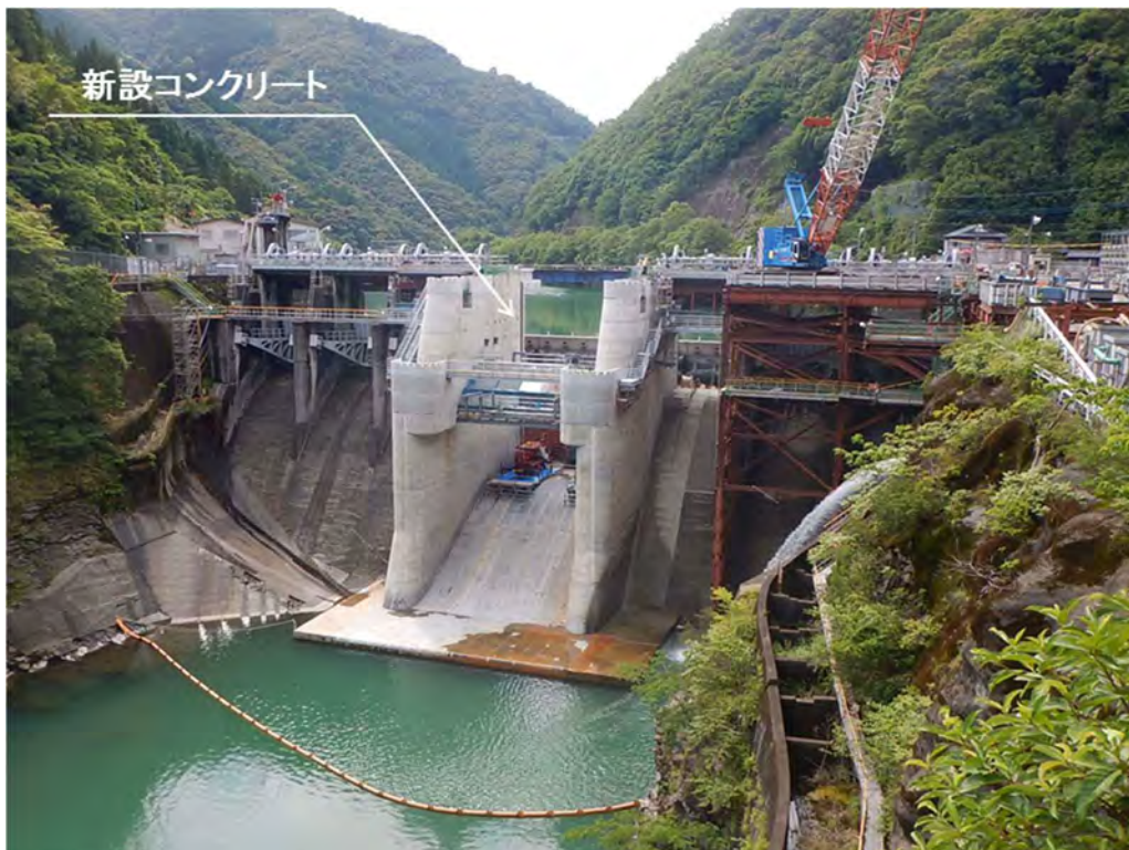
写真 6.1.6 ダム堤体構築後（ダム下流左岸より上流を望む）
