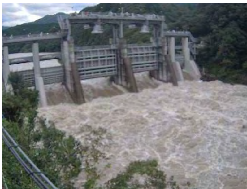
写真 6.2.2 西郷ダムでの通砂状況(台風 24 号；9/30 15 時)
