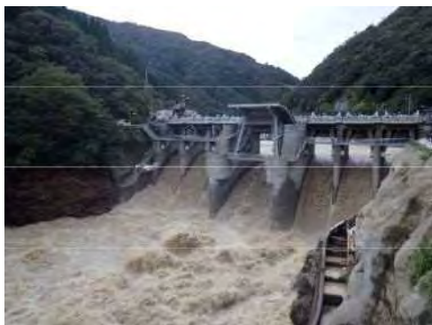
山須原ダムでの通砂状況(台風14号；9/19 16時)
