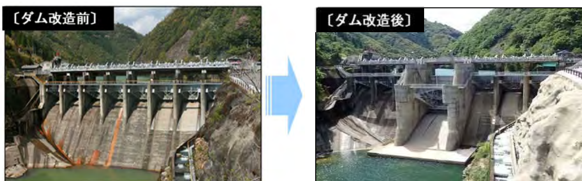
写真 6.1.1 山須原ダム改造工事概要
