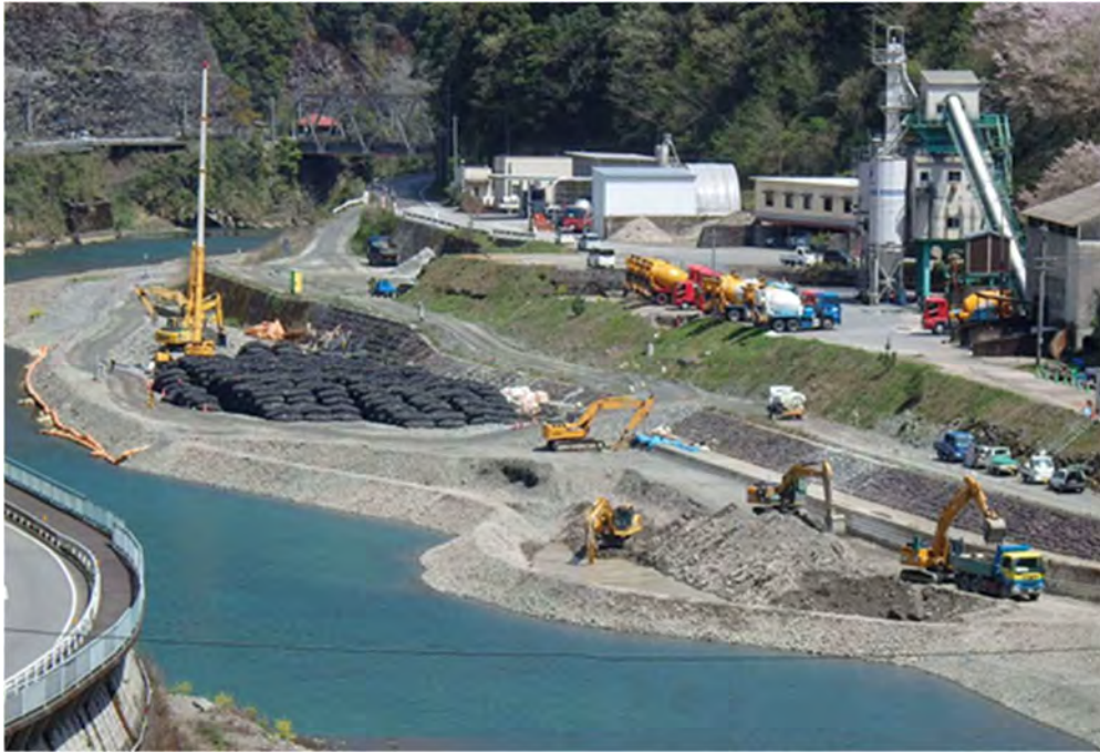
写真 6.1.12 諸塚中心部周辺の土砂浚渫状況
