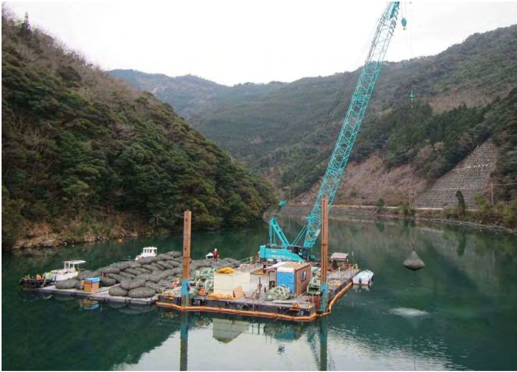
写真 6.1.17 袋詰玉石の据付
