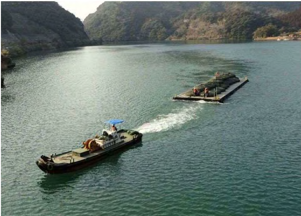
写真 6.1.18 袋詰玉石の水上運搬
