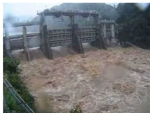
西郷ダムでの通砂状況(台風14号；9/18 12時)
