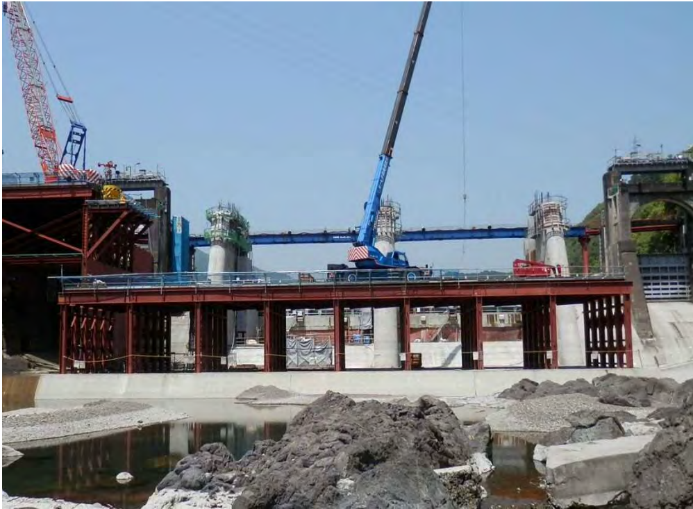
写真 6.1.9 ダム堤体構築状況（ダム下流より上流を望む）
