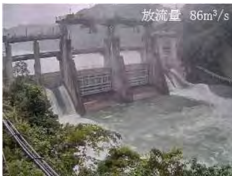
写真 6.2.4 西郷ダムでの通砂状況(台風9号；8/8 14時)
