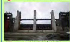
工事中(H26年12月)
