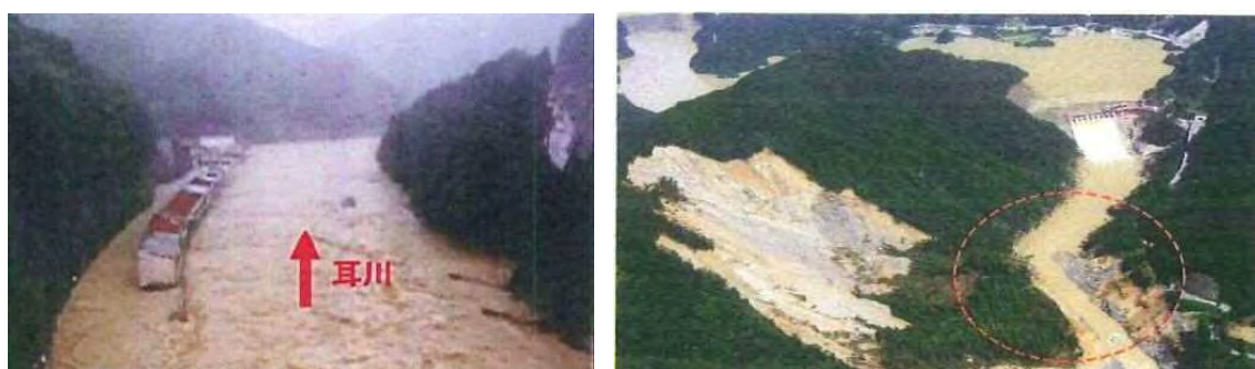
図 1.1.1 H17 年 9 月台風被災状況(左図：諸塚地区，右図：塚原ダム直下)
