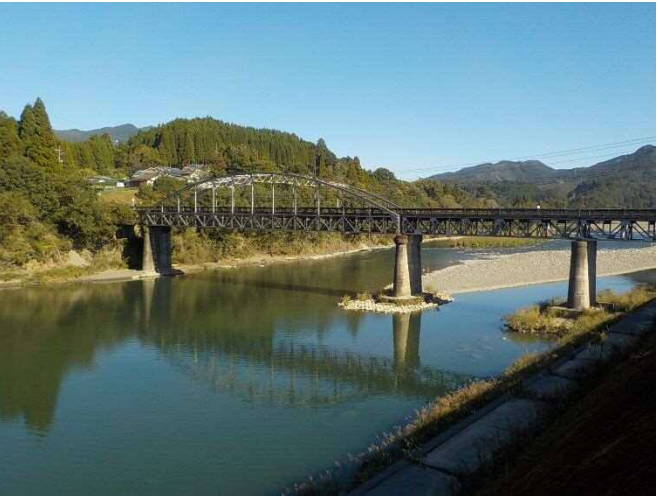
八重原橋：令和5年11月14日撮影
