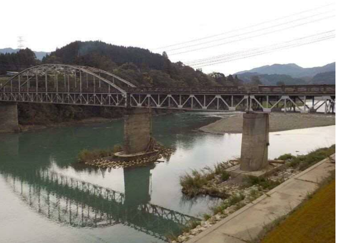
八重原橋：令和4年11月17日撮影
