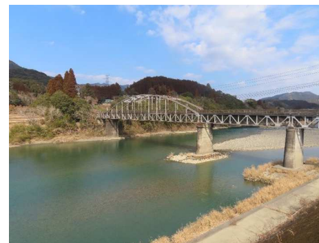
八重原橋：令和6年12月1日撮影
