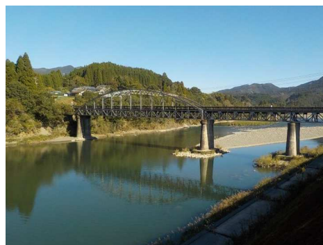
八重原橋：令和5年11月14日撮影
