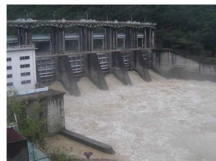
大内原ダム（台風最接近時から約1日後）
