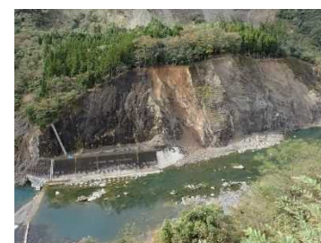
大規模崩壊跡地：塚原ダム下流 野ノ尾地区(R3 秋撮影)
