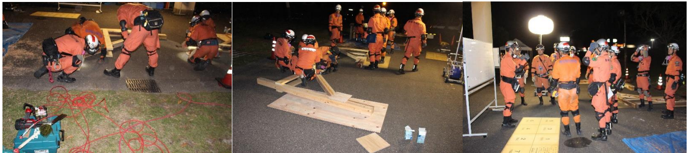
補強材を入れて構造物の安定化を行った。
