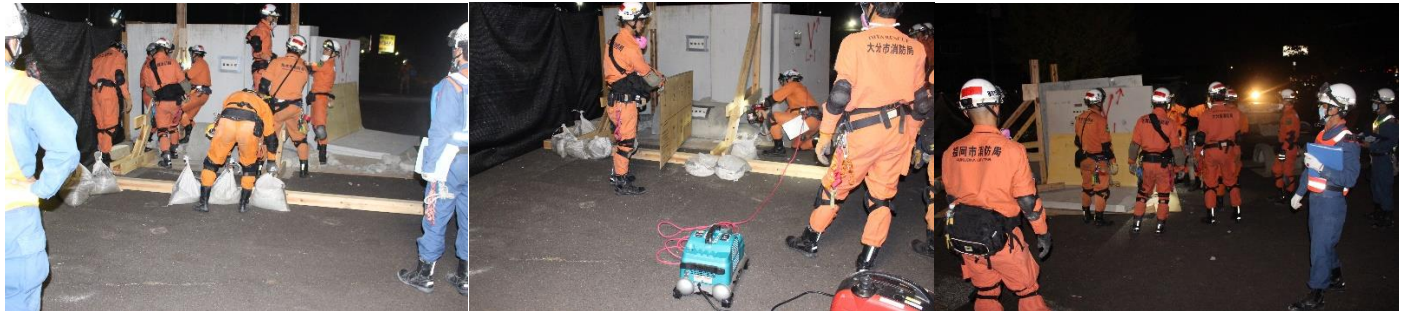
補強材を入れて構造物の安定化を行った。
