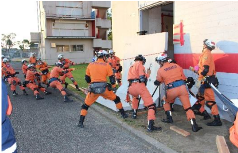
開口部に亀裂があるためショアリングを行った。
