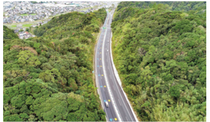
鹿児島県 隼人道路4車線化
