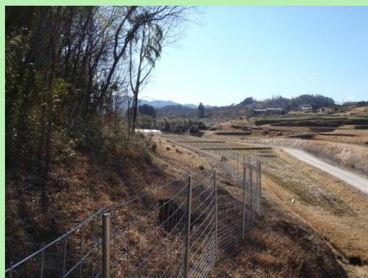
管理道を確保した柵設置(H30.2月)
