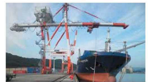
▲ガントリークレーン
