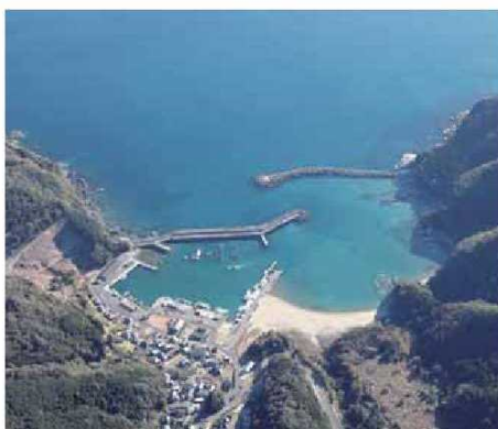
(直海地区) 令和2年11月撮影
