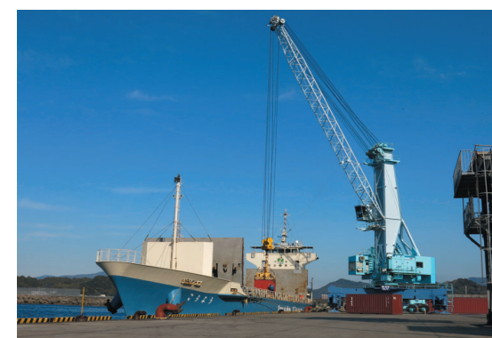
▲コンテナ船荷役状況
