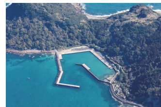
小場浜地区 令和5年2月撮影
