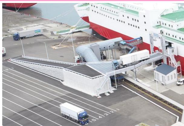
**サイドスロープ(車輛乗船用可動橋)設置により、荷役時間短縮(2時間50分から1時間40分に)**
