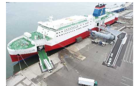
宮崎港サイドスロープ
