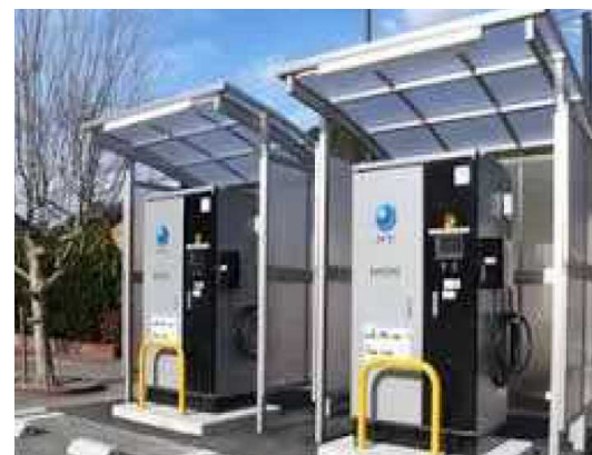
EVバス充電施設の設置
