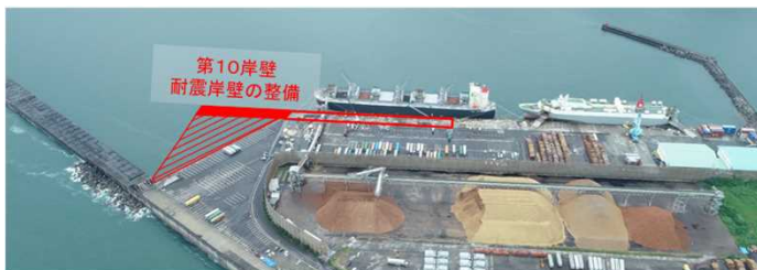
油津港の耐震岸壁整備
