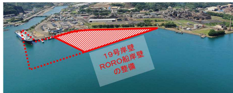
細島港19号岸壁整備
