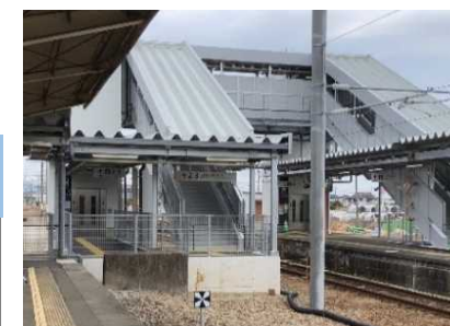
JR佐土原駅のバリアフリー化 (エレベーター付き跨線橋整備)
