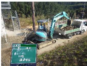
積込状況写真
