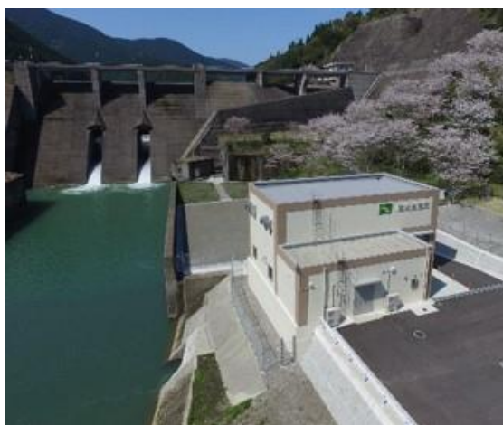
酒谷発電所と日南ダム
