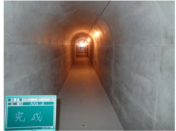
トンネル内部
