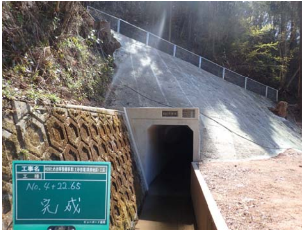
トンネル坑口
