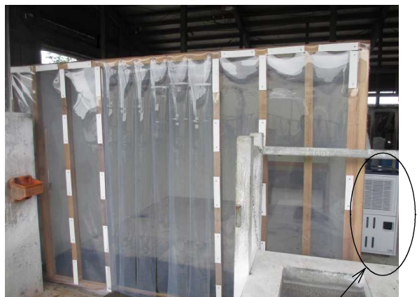
スポットエアコン
